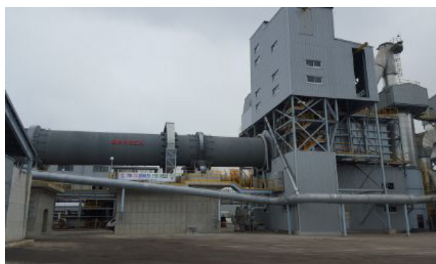
Illustrasjon og bilde av Befesas gjenvinningsanlegg for EAF-støv. 104 Et av anleggene som kan gjenvinne EAF-støv fra Norge.
