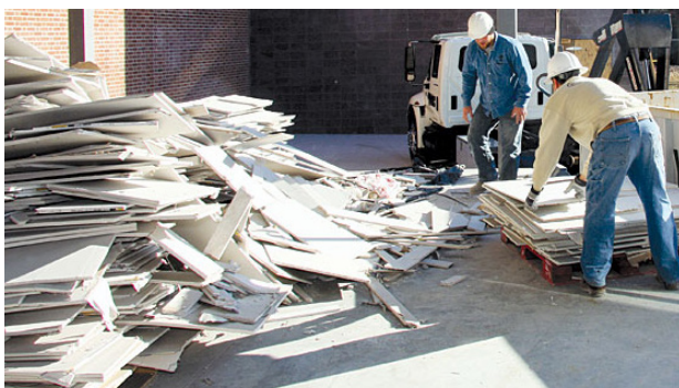
◀ Til venstre, sortering av gipsplater til gjenvinning i USA, 28 ▶ til høyre bilde av gipsgjenvinningen til Norsk Gjenvinning i Holmestrand. 29
